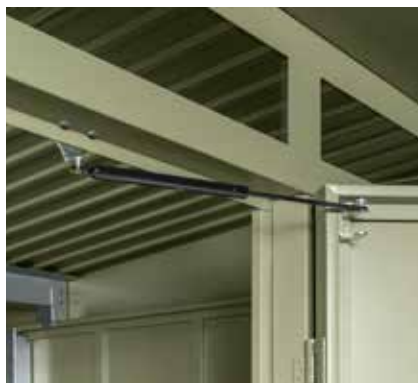
Mechanická zaistovacia jednotka s plynovou pružinou
